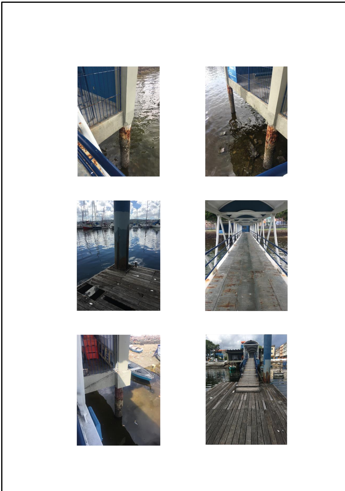
Figura 7 - Situação atual do Terminal da Ribeira
