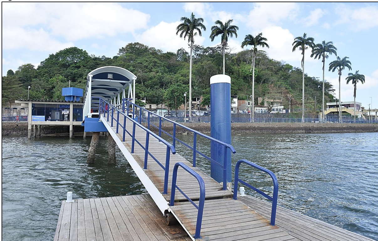
Figura 3 - Terminal Marítimo de Plataforma
