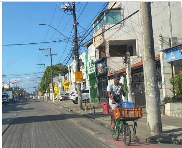
Figura 90 - Ciclovía na R. Procurador Nelson Castro (largura insuficiente para ser bidirecional)
