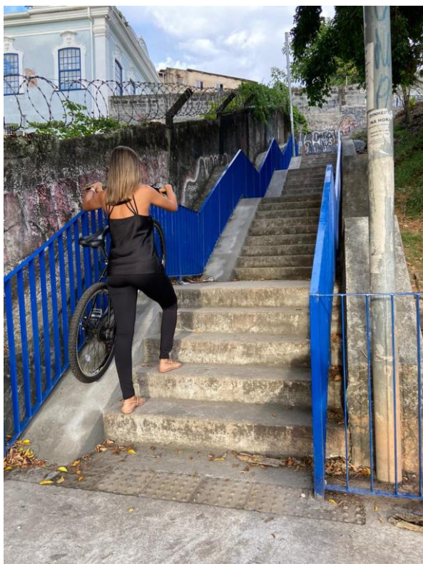
Figura 96 – Escadaria com solução de rampa adequada para o fluxo de bicicletas Fonte: Alô Alô Bahia
