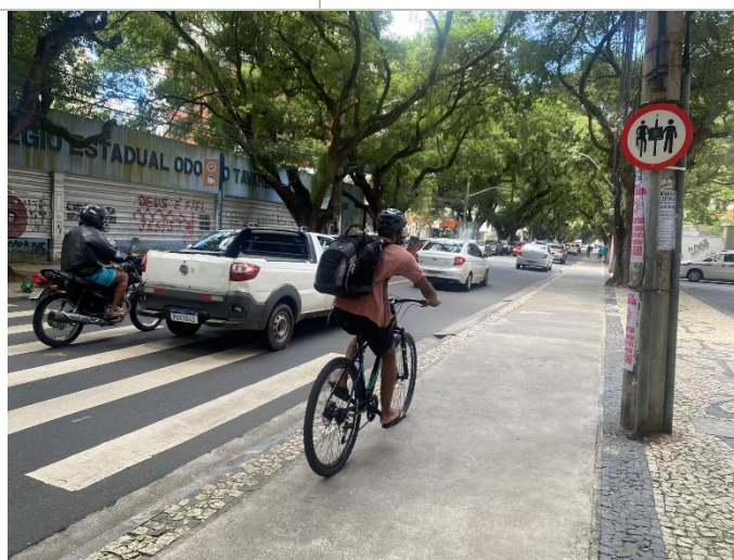
Figura 94 - Ciclovía na Av. Sete de Setembro (largura bidirecional de 1,80m, menor que a largura recomendável de 2,50m)
