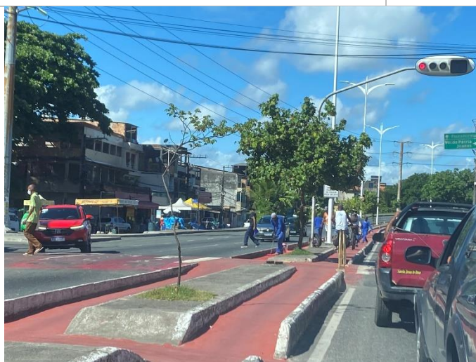
Figura 88 - Ciclovia R. Amazonas (Pituba) com largura de 0,80m
